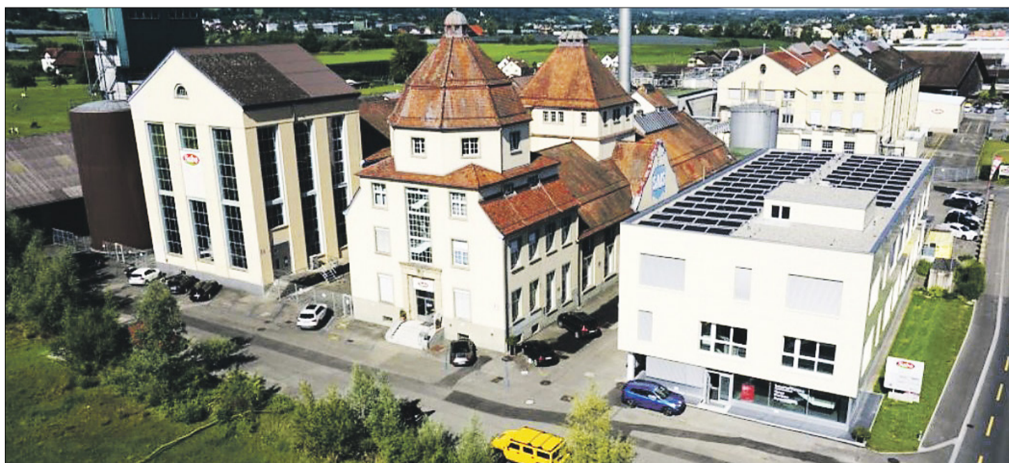
Das 40000 Quadratmeter grosse Werkareal der Sabo liegt an der Hauptstrasse Arbon-Rorschach, zwischen Bodensee und der Bahnlinie. (Bild zvg)
